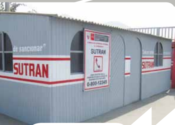
Puesto de Control. Fotografía: SUTRAN.
